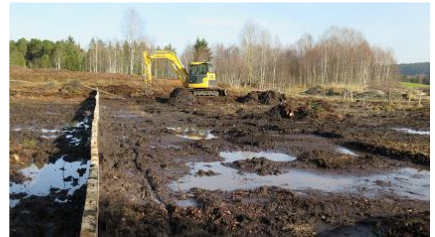
Décapage de sol dans une tourbière du Jura (CEN Franche-Comté)
