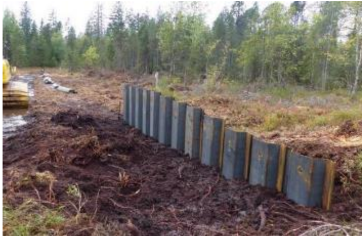
Neutralisation d'un fossé drainant dans une tourbière du Jura (CEN Franche-Comté)
