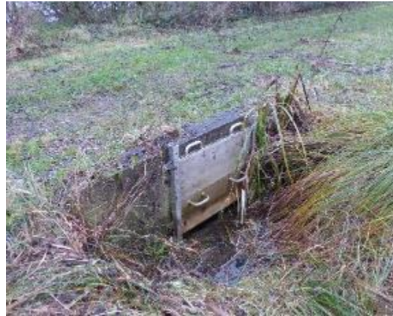
Seuil pour gérer les niveaux d'eau au marais de Blangy-Tronville (80) (CEN Hauts-de-France)
