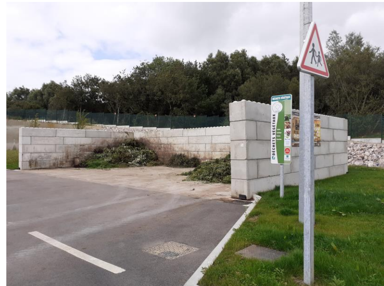
Plate forme de 200 m2
